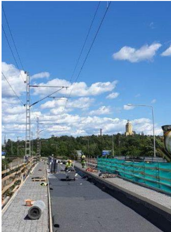
2019: SILTA- JA VAIHDETÖITÄ
