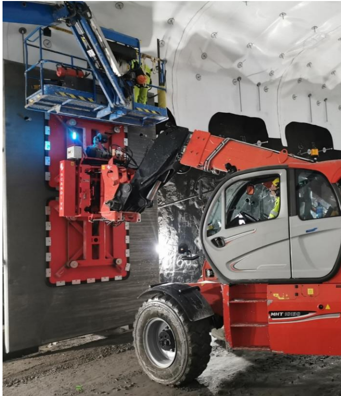
Tukholman ohikulkutie: sisustus- ja betonityöt
